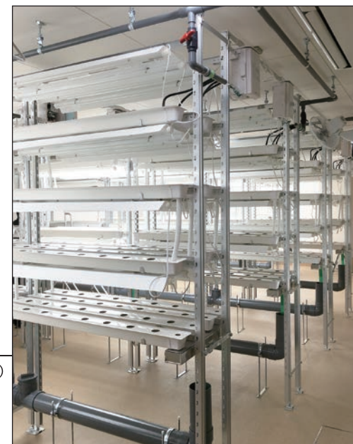
■ 水耕栽培ユニット 多段式6段タイプ×20台 連結式(3,840株) ※LED/FL：480灯 (有効天井高 約3.0m～3.2m)
